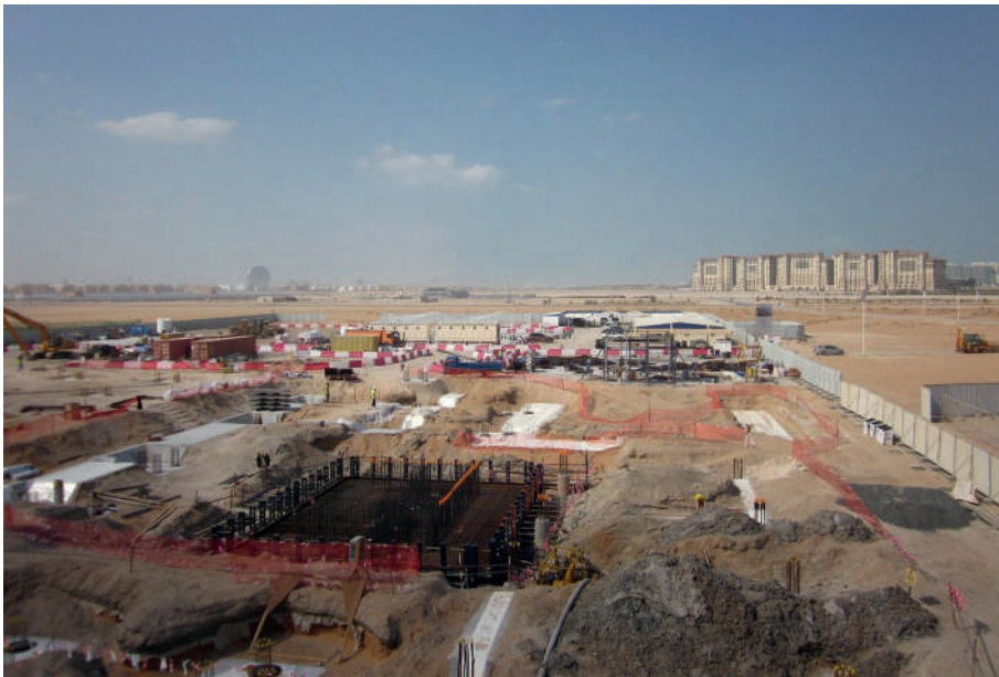
Masdar City – zrównoważone miasto ZEA w trakcie budowy
